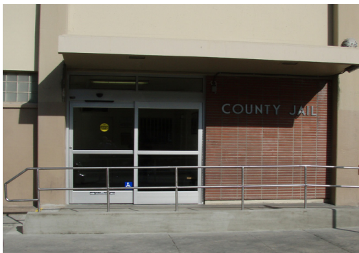
La nueva rampa ya instalada
